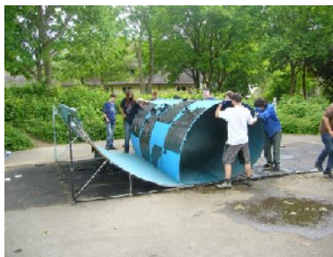
Abbau der Halfpipe
